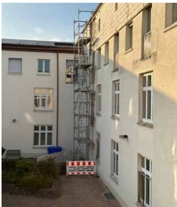
Neubau eines Aufzugs am Verwaltungsgebäude Adam-Müller-Straße 69
