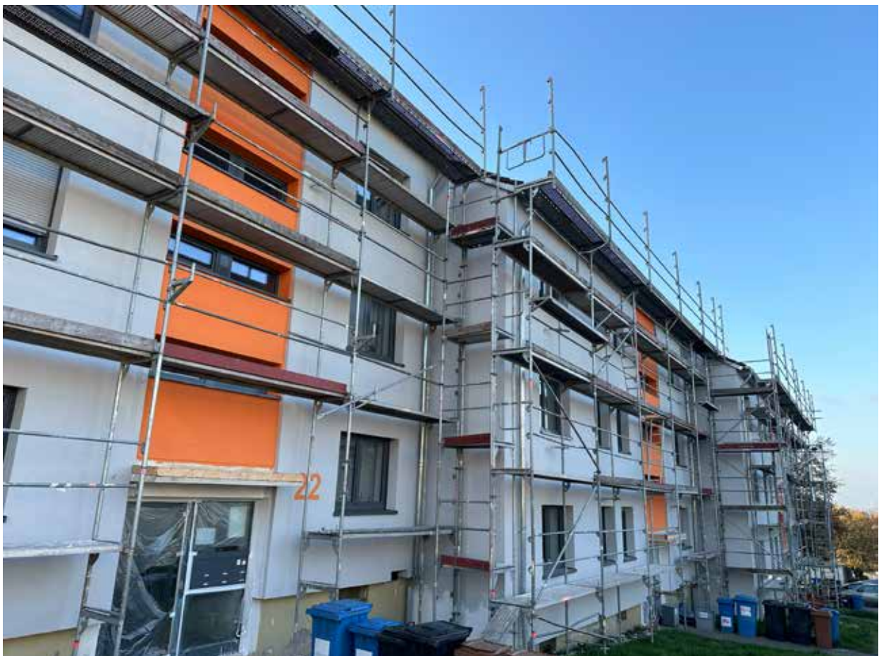
Modernisierung An der Ziegelhütte 18-22
