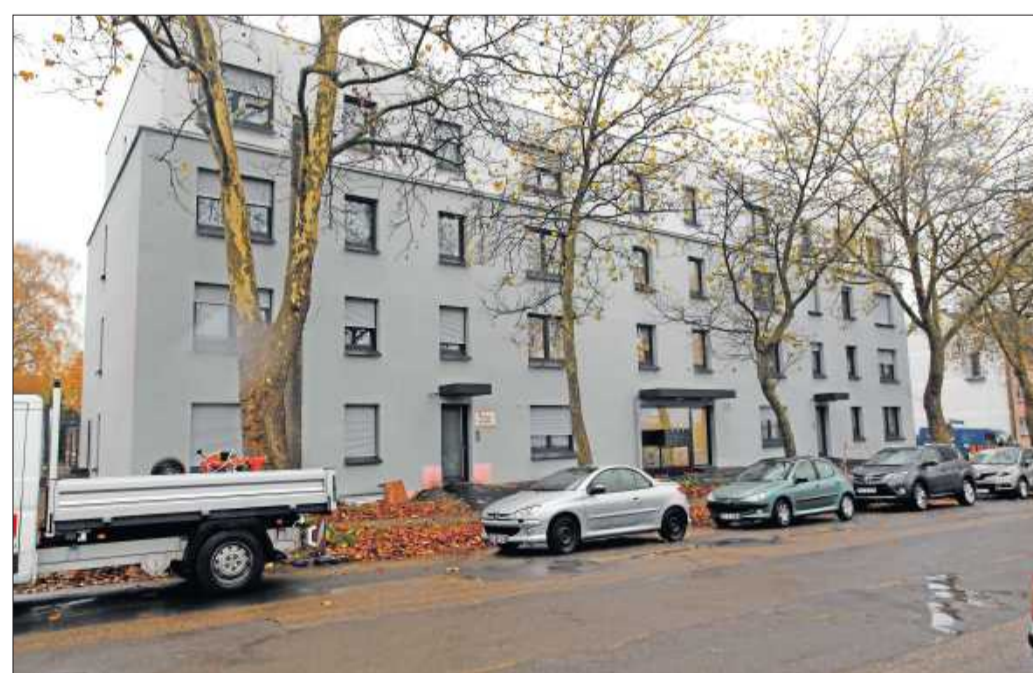
In der Winzler Straße ist der zweite Bauhilfe-Block eingeweiht worden.
