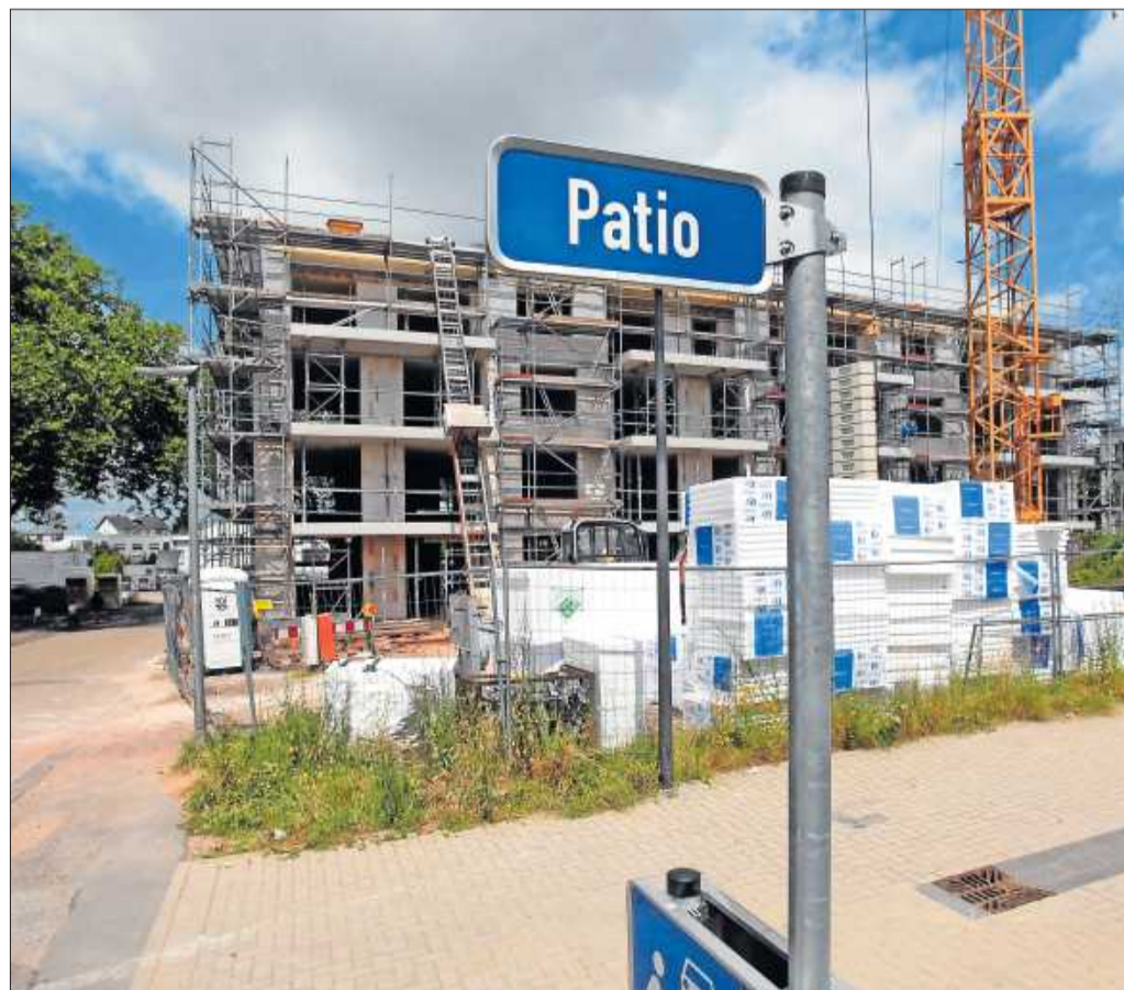
Aus dem Rohbau ist inzwischen ein fertiges Gebäude geworden. (Foto: Archiv/Scharf)
