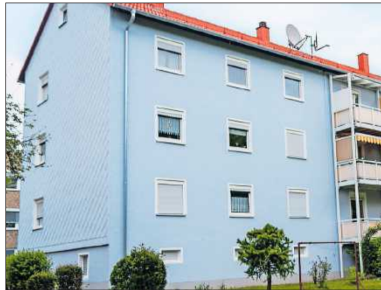
Neues Dach und neuer Fassadenanstrich: In der Hans-Sachs-Straße ist investiert worden. FOTO: BAUHILFE/FREI
