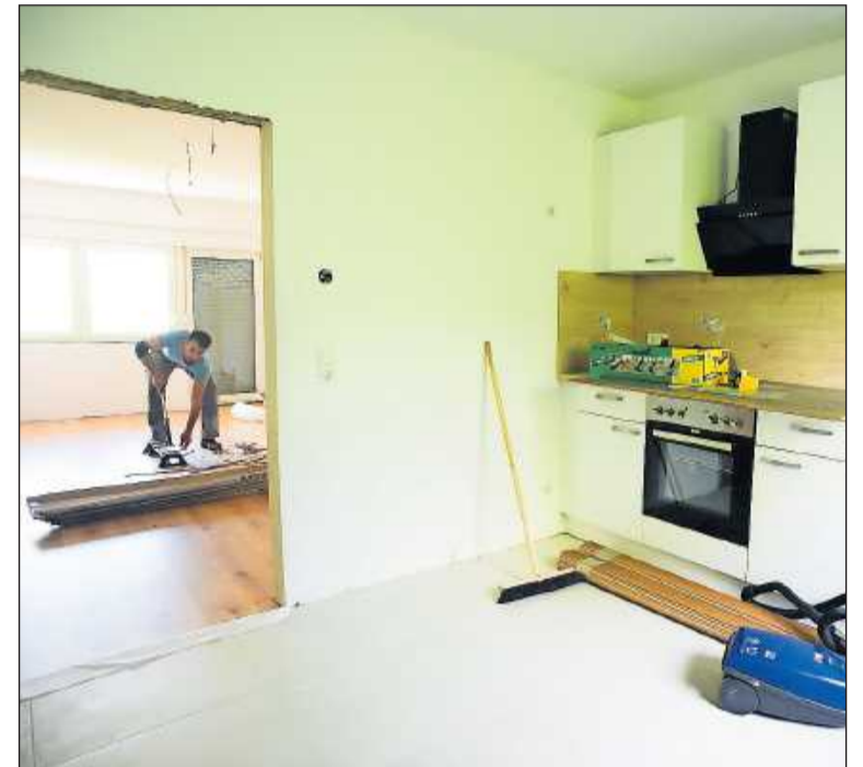
Die Küchenzeilen mit Herd und Kühlschrank sind schon eingebaut, auf dem Boden wird Eichenlaminat verlegt. FOTO: SEEBALD
