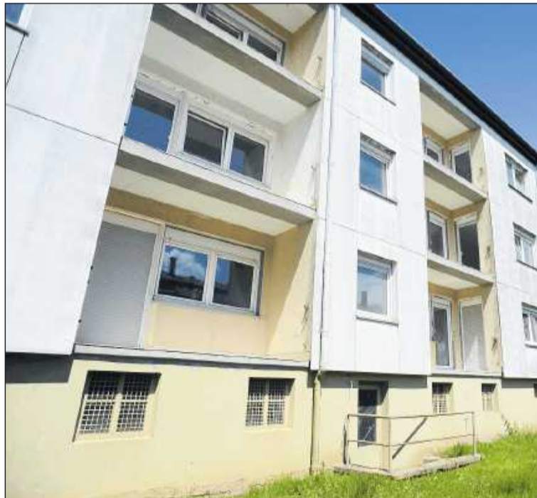
In den Tannen geht es voran: Außen fehlt noch der neue Anstrich, die Balkone sollen Edelstahlgeländer erhalten. FOTO: SEEBALD
